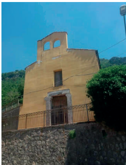
Facciata Chiesa Madonna del Carmine sita nei pressi dell'abitazione dell'Abate
